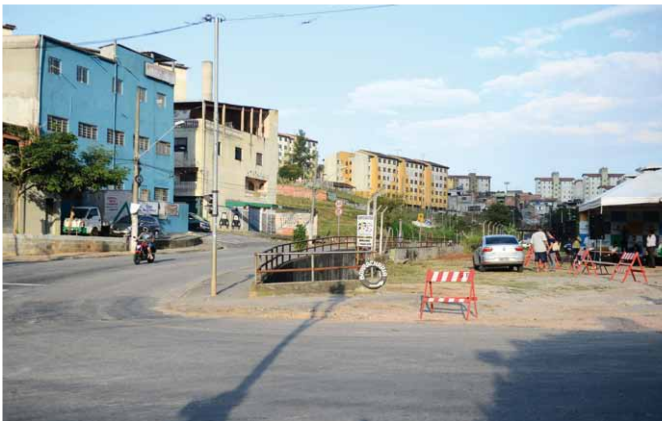
São Bernardo inicia obras de prolongamento da Av. Juscelino Kubitschek
